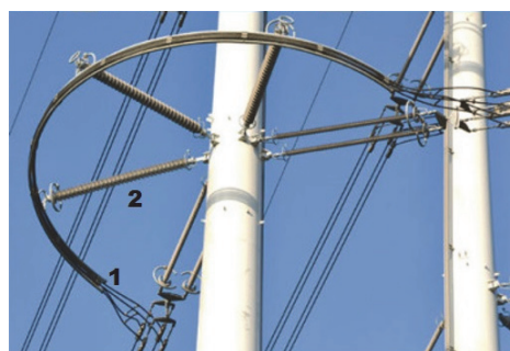
Rys. 7. Mostki prądowe (1) podtrzymywane izolatorami wsporczymi (2) w linii 400 kV [23]
