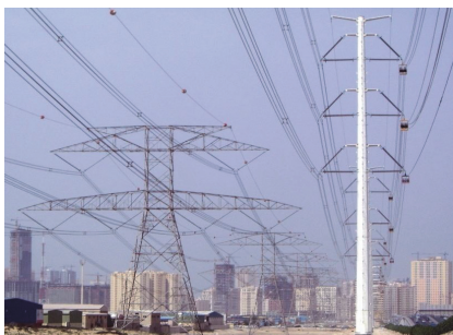
Rys. 10. Linia tradycyjna i kompaktowa 420 kV w Dubaju [25]
